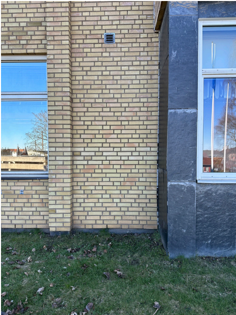
Mötet mellan tillbyggnad från 1980 och ursprunglig del.
