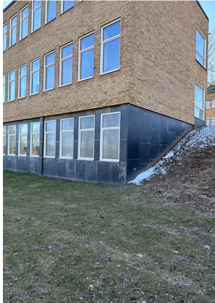
Källarvåning mot väster.
