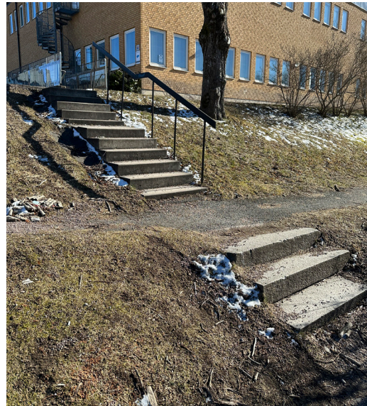
Vissa av byggnaderna ligger i sluttningar och är utförda med souterängväning. Bilden visar trappa mot A-huset.
