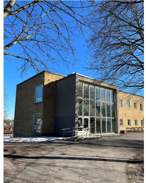
Stora fönster på gavlarna, på insidan finns skolkorridorer.
