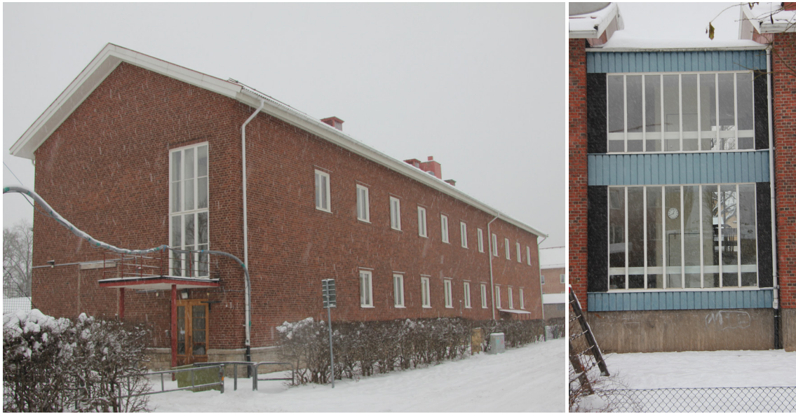
Norrmalmsskolan (kv Kornet, Vallevägen) uppfördes 1933 och har en välbevarad 1930-talskaraktär, där tillbyggnaderna kompletterar den ursprungliga anläggningen. Enligt Skövde kommuns kulturmiljöprogram är detta en av de kulturhistoriskt viktigaste skolmiljöerna från 1900-talets Skövde.
