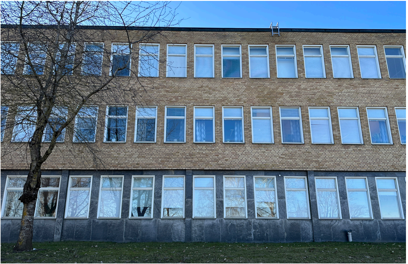
Fasad mot öster med regelbunden fönstersättning, sockelväning i skiffer och fasader i gult tegel.
